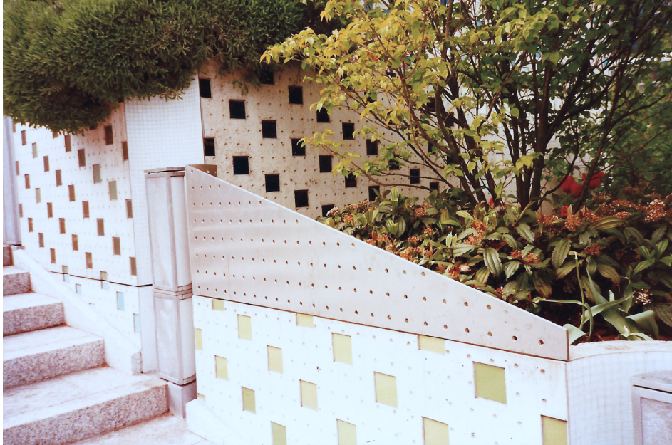
Slika 1: Distančni utori, prekriti z kamnito ploščico 10 / 10 / 1,5 cm
